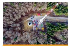
den. Der Hybrid-Turm (Beton-Stahl) ist nicht nur die Statik für das Turbinenhaus, sondern auch Versorgungs- und Kontrollschacht der Windkraftanlage.
